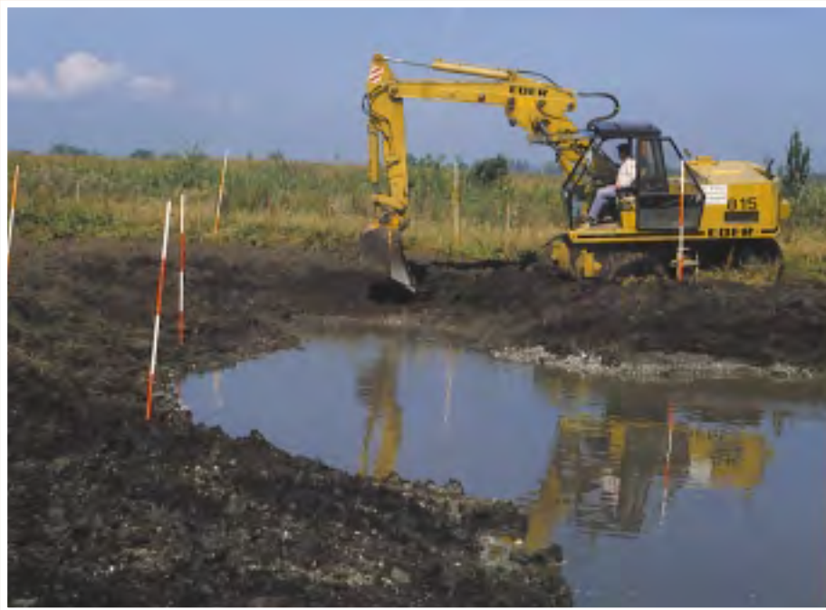
Anlage von Feuchtbiotopen als Ausgleichs- oder Ersatzmaßnahme beim Straßenneubau
